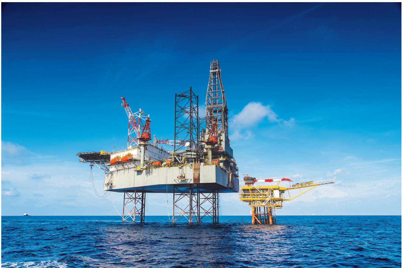
Bild 2) Die Einsatzbereiche für ex-geschützte Motoren sind vielfältig. Auf Bohrinseln mit bestimmten explosionsgefährdeten Bereichen können die Beine, die abgesenkt werden, mit Ex-Motoren bestückt sein. Bildnachweis: iStock | pichistocke
